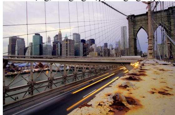
Hình ảnh một số công trình thép bị gỉ
